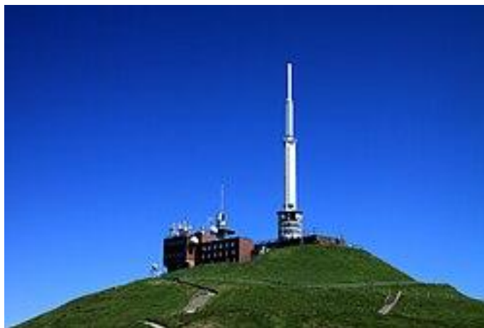
Laboratoire et pylône de TDF.
