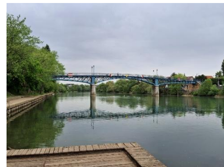
Passerelle de Bry / Photographe Aridd - Wikipédia
